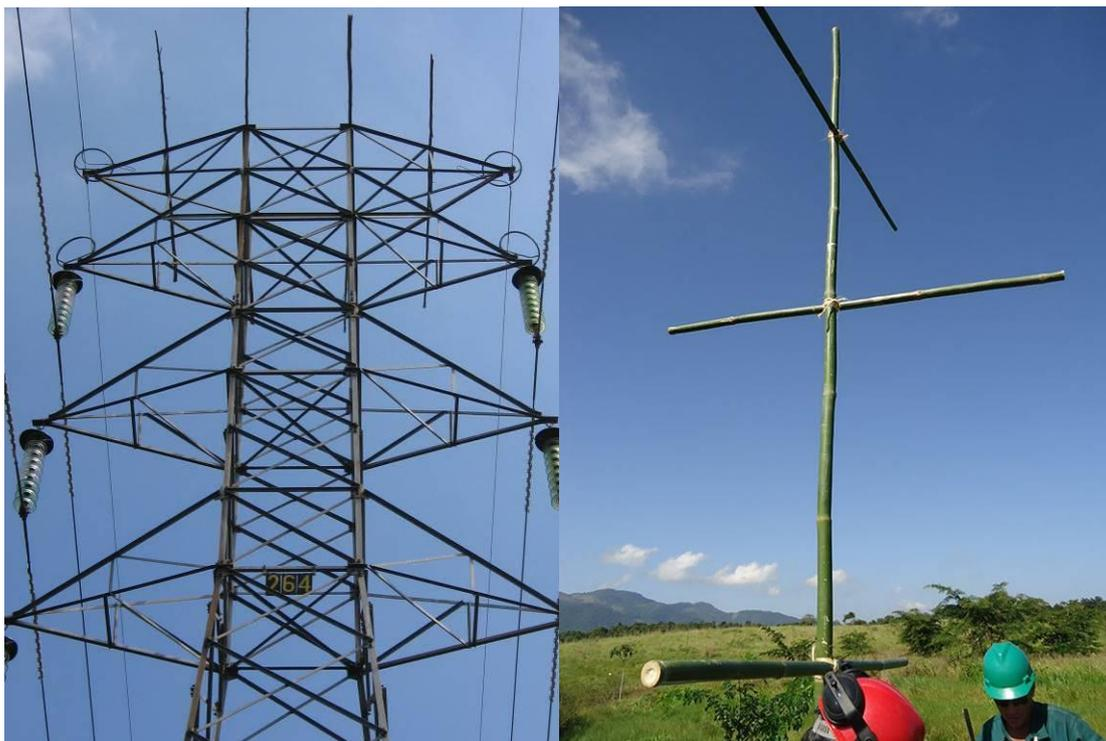
Figura 23 – Poleiros para acomodar as Curicacas fora da projeção dos condutores e fora das estruturas
