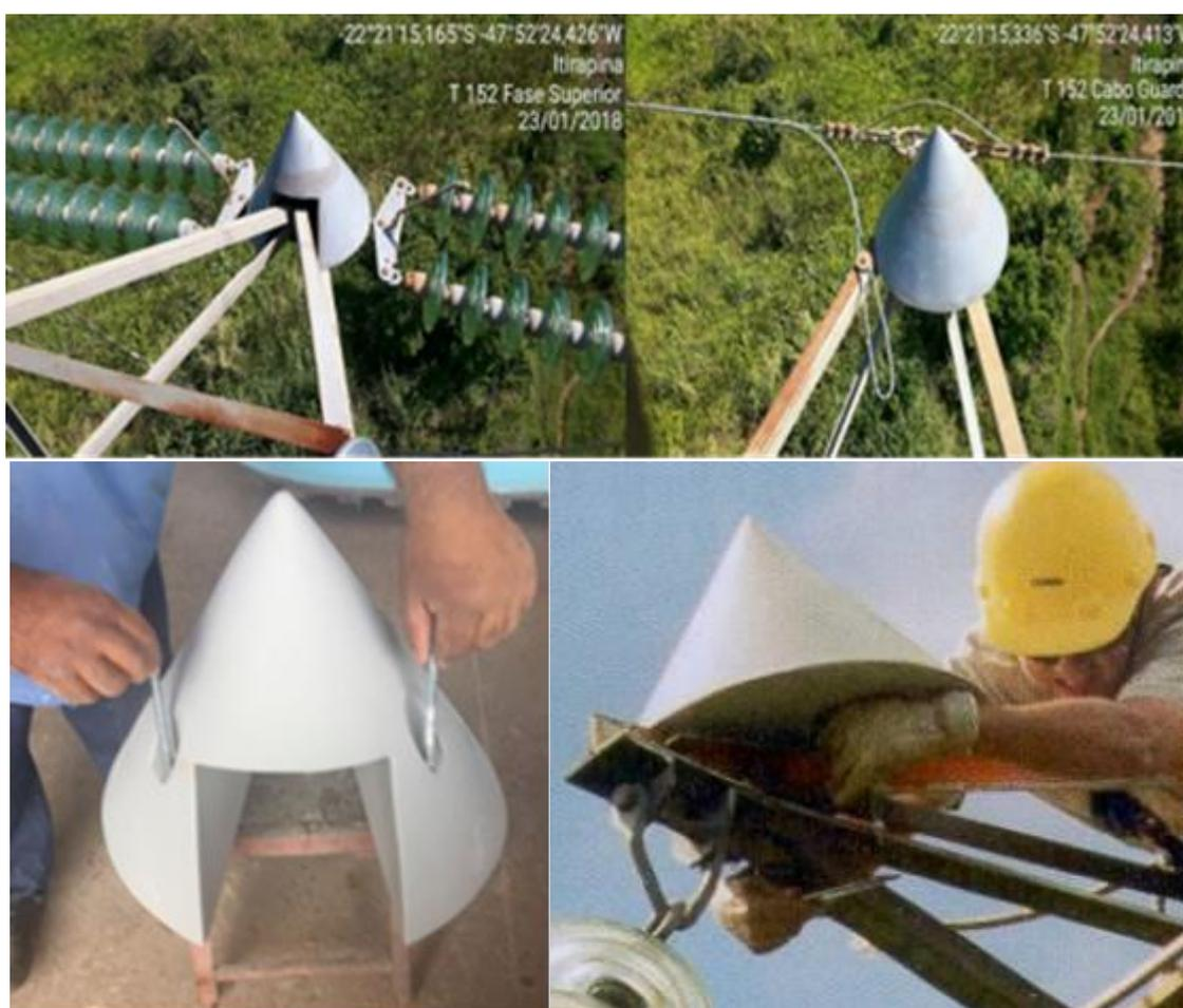
Figura 26 – Cones de Instalação nas Pontas das Mísulas
