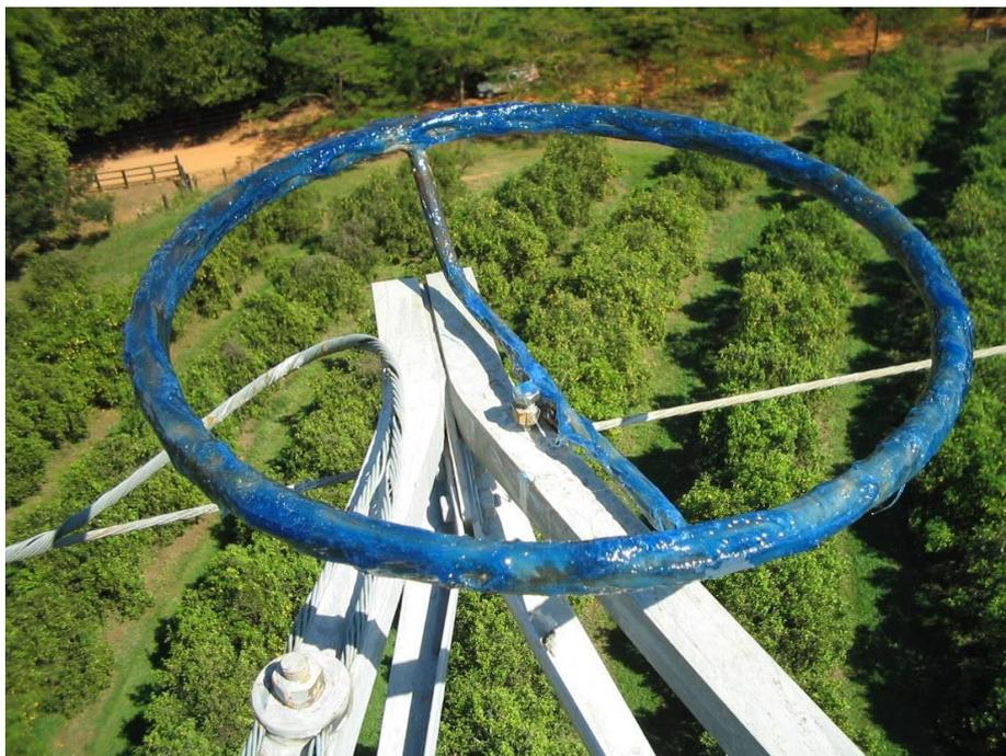
Figura 25 – Fixação de Anel Equalizador com Repelente Pastoso na Extremidade da Mísula
